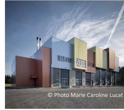
Trigénération au bois - Montpellier
