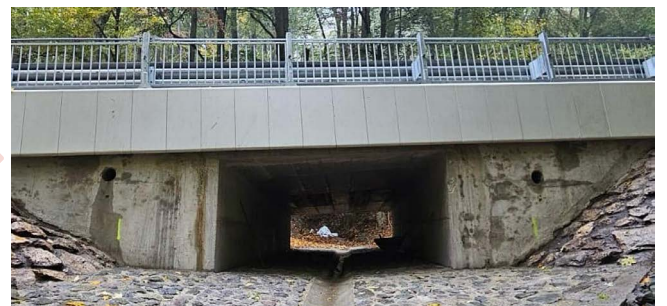
Oprava mosta na ceste II/503 na Pezinskej Babe (po dokončení)
